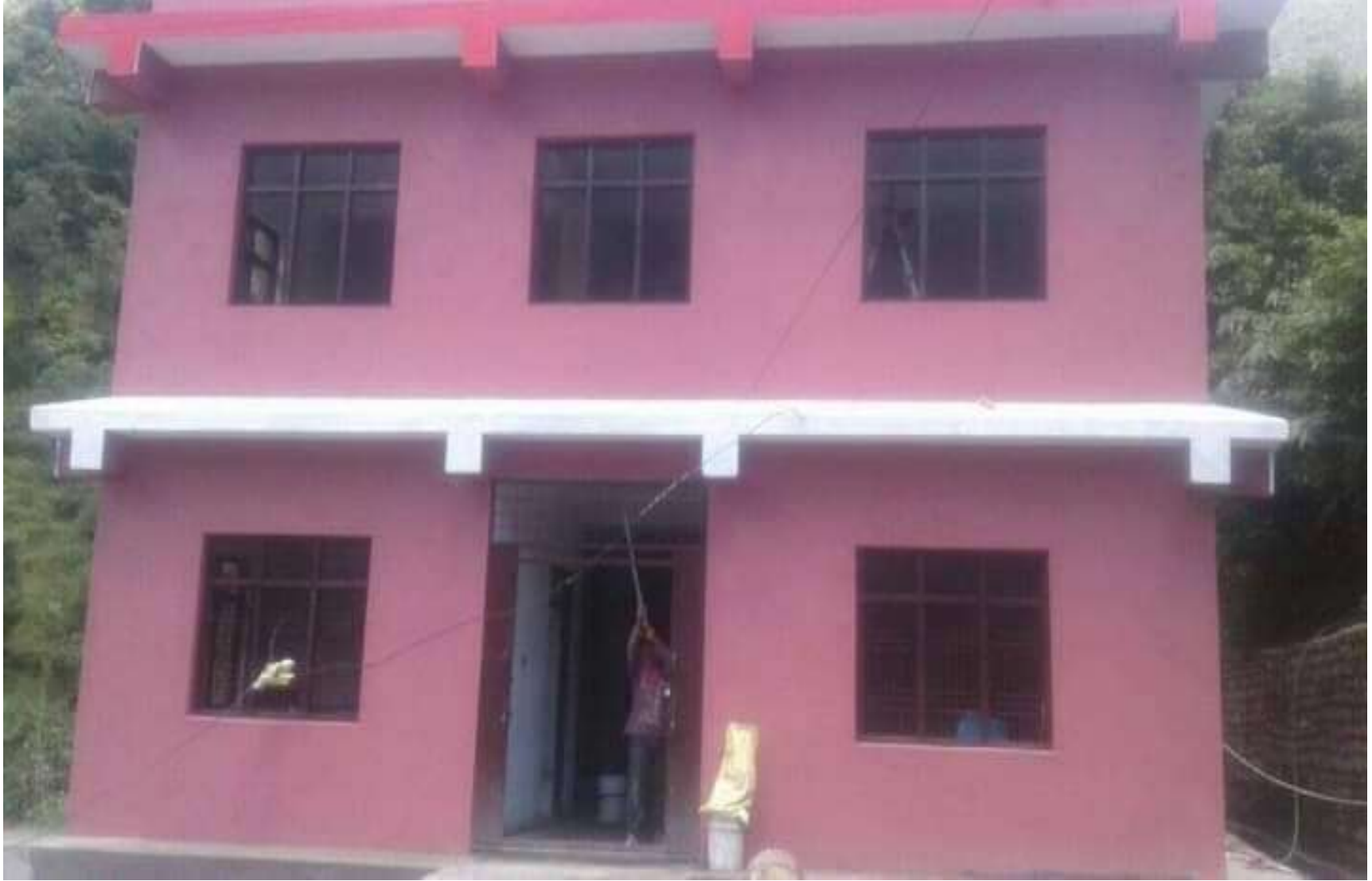
बडिगाड ५ को निर्माणाधिन वडा कार्यालय भवन
